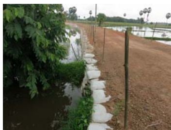
②施工後: 施工道路周辺は冠水しているが嵩上げ工事により、雨期時の通行も可能となっている。
