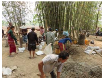
④作業風景
